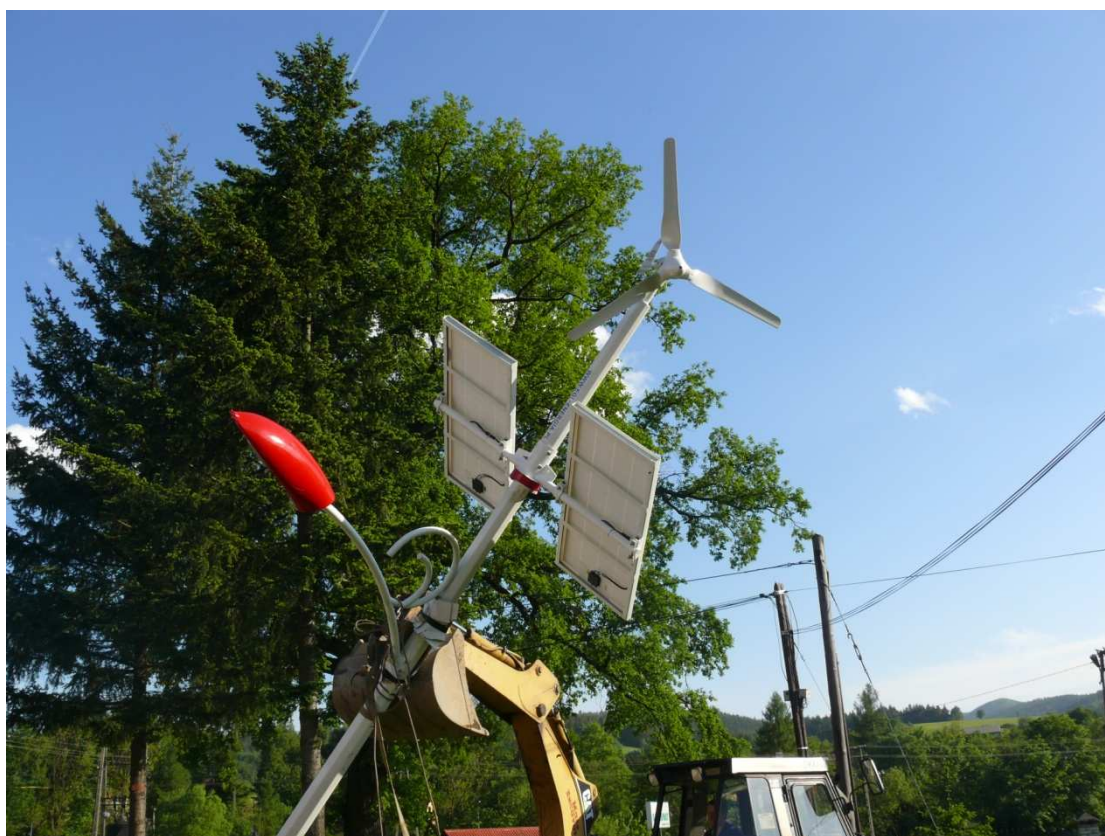
Fot. 2 i 3, Zdjęcia z placu budowy w Łabowej, woj. Małopolskie
