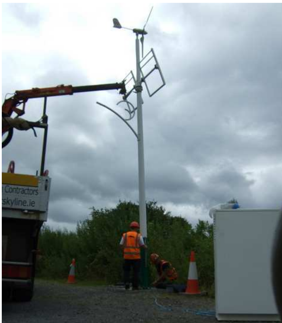
Fot. 6, Plac budowy w Łabowej, woj. małopolskie
