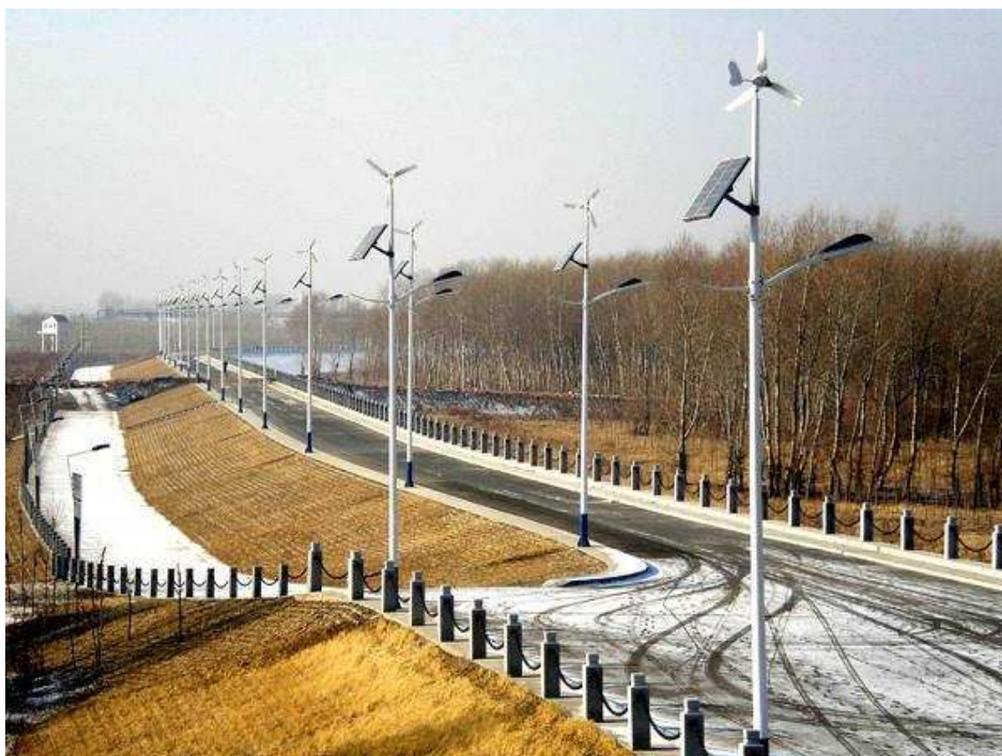
Fot. 7, Przykładowa realizacja
