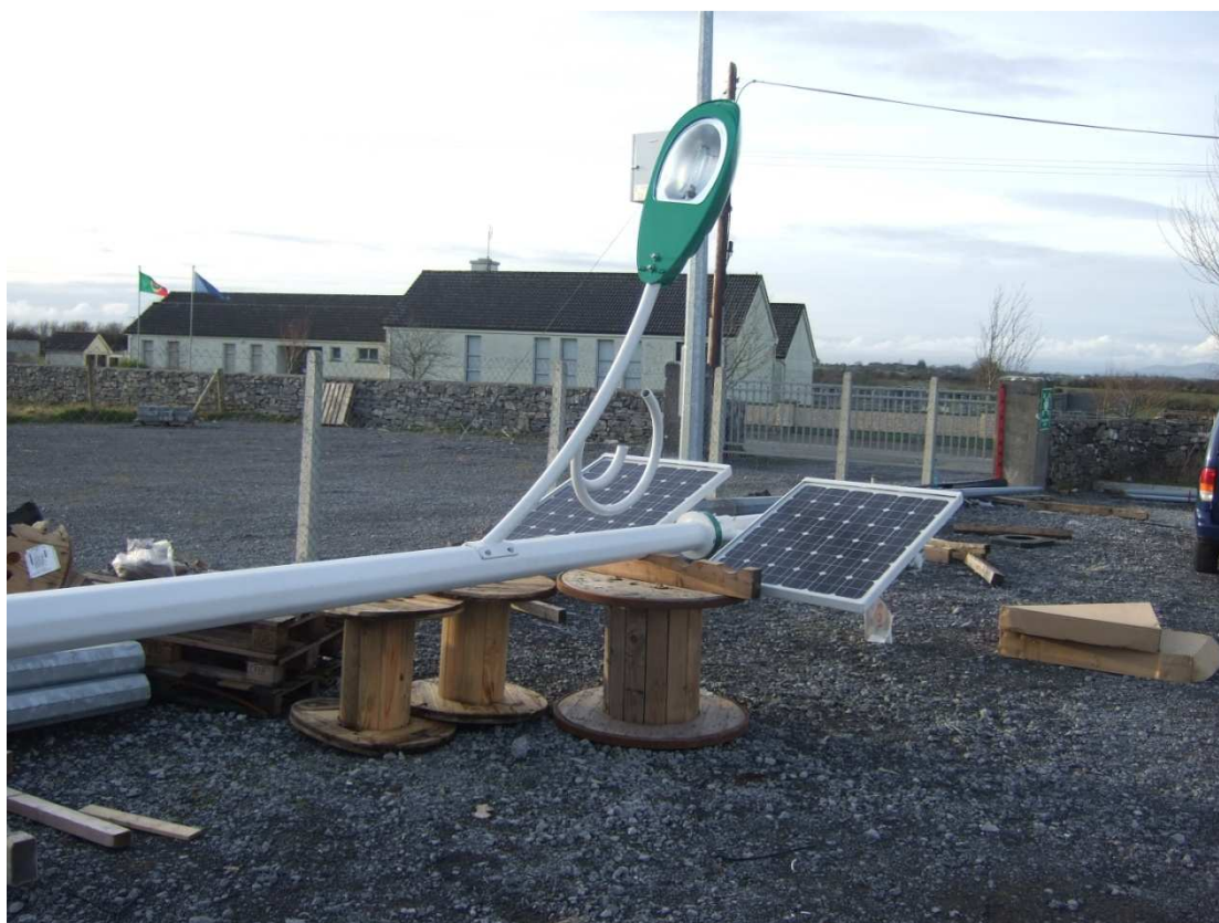
Fot. 4 i 5, Zdjęcia z placu budowy w Łabowej, woj. Małopolskie
